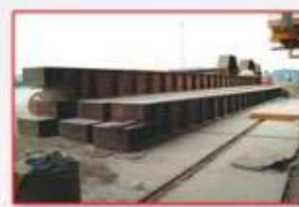
ساخت SKID BEAM های شرکت مهندسی و ساخت تأسیسات دریایی ایران بطول ۲۴ متر و وزن هر شاخه ۲۵۷۰۰ کیلو گرم بطول کلی ۳۲۶ متر
