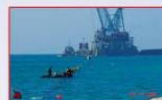
انجام عملیات Shore Pulling لوله های ۳۲ اینچ پروژه سلمان و مبارک در جزیره سیری جهت شرکت پترو ایران
